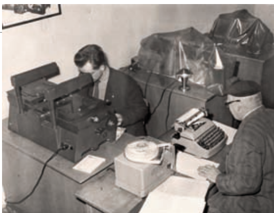
Odečítání souřadnic leteckých snímků a jejich záznam na děrnou pásku, stereokomparátor firmy Zeiss. ÚHÚL, 60. léta 20. století. / Reading coordinates of air photos and recording them on punched tape, Zeiss stereocomparator. FMI, 1960s.
