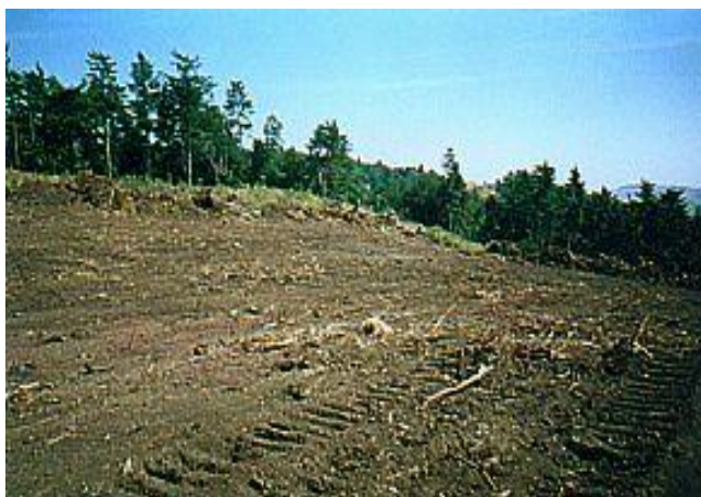
Obr. 4.12.3: Rýhová eroze vzniklá při nedostatečné údržbě lesní cesty
